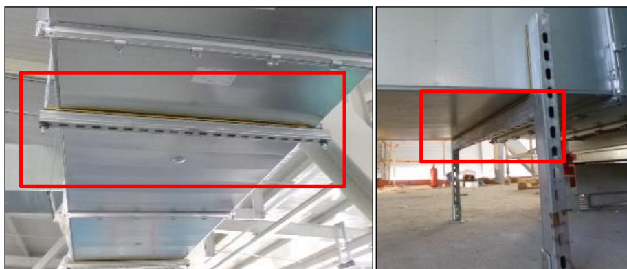
Figure 24 : Exemple de bande souple Dammgulast jaune de MUPRO
