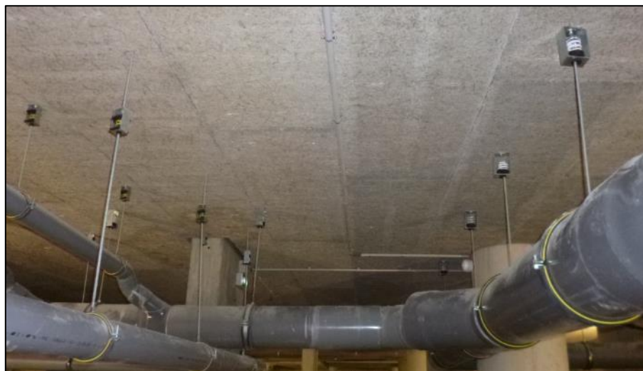
Figure 23 : Exemple de réseaux désolidarisés par suspentes à ressorts
