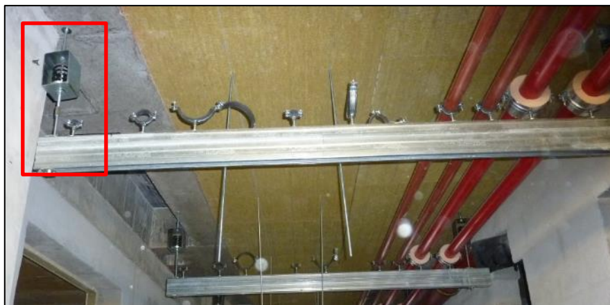
Figure 22 : Exemple de support de réseaux désolidarisés
