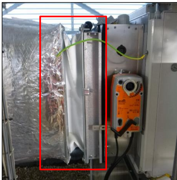
Figure 20 : Exemple de manchette souple au raccordement avec une CTA
